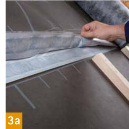
Die Verklebung der Bahnenüberlappung der SOLITEX MENTO connect erfolgt durch die zwei integrierten Selbstklebezonen staubgeschützt und sicher Kleber auf Kleber. Es entsteht eine sofort extrem feste Verbindung – auch unter Feuchteinfluss.
