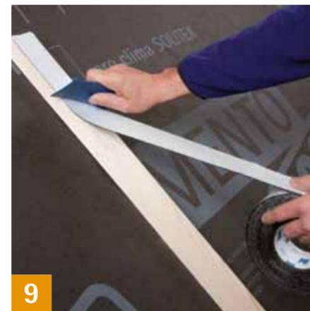
Zur Erstellung eines regensicheren Unterdachs muss das Nageldichtungsband TESCON NAIDEC zur Abdichtung zwischen Konterlattung und SOLITEX MENTO eingebaut werden.
