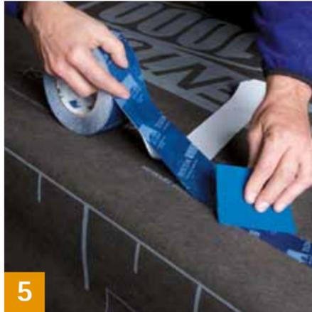
Bei vollgedämmten Querschnitten Bahnen über den First/Grat führen und mit Klammern im Bereich der Konterlatte befestigen. Überlappung auf die darunter liegende Bahn mindestens 10–15 cm. Bahnenüberlappung mit den Allround-Klebebändern TESCON No.1 / TESCON VANA verkleben. Alternativ breite Überklebung des Firsts mit TESCON VANA in 15 cm Breite.
