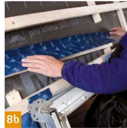
Montage eines Wasserabweisers oberhalb des Dacheinbauteils durch Einbau einer Latte mit Quergefälle. Latte mit TESCON No.1 oder TESCON VANA auf der Unterdachbahn verkleben. Die Abweiser so ausbilden, dass Feuchtigkeit durch eine unterbrochene Konterlatte in das nächste angrenzende Feld ohne Dacheinbauteil geleitet wird.
