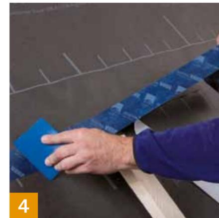
Verklebung der Bahnenüberlappungen bei SOLITEX MENTO Bahnen und bei Kopfstößen mit den einseitigen Allround-Klebebändern TESCON No.1 / TESCON VANA.
