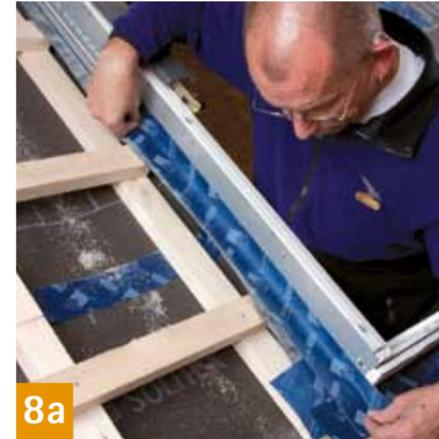
SOLITEX MENTO Bahnen an glatten Oberflächen wie Dachfenstern, Schornsteinen, Rohren und anderen Dacheinbauteilen mit den Allround-Klebebändern pro clima TESCON No.1 oder TESCON VANA anschließen. Glatte mineralische Oberflächen sind zuvor mit TESCON PRIMER RP zu grundieren.
