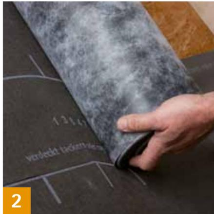
Bahnen mit 10-15 cm Überlappung verlegen. Die aufgedruckte Markierung dient dabei zur Orientierung.
