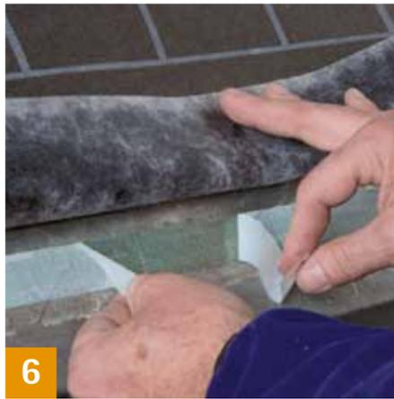
SOLITEX Unterdachbahn muss wasserführend an der Traufe angeschlossen werden. Bahn dazu auf ein Traufblech bzw. einen Traufstreifen führen. Mit der integrierten Selbstklebezone, doppelseitigem Klebeband pro clima DUPLEX oder dem einseitigen TESCON No.1 / TESCON VANA faltenfrei verkleben.
