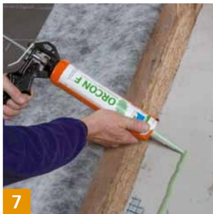
Der Anschluss an raue Untergründe wie z. B. hier am Ortgang erfolgt mit den Anschlussklebern ORCON F oder ORCON CLASSIC. Kleberaube mit ca. 5 mm Durchmesser auftragen. Bei rauen Untergründen ggf. mehr.
