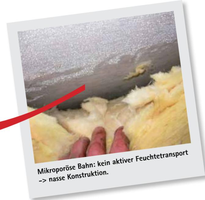
Mikroporöse Bahn: kein aktiver Feuchtetransport -> nasse Konstruktion.
