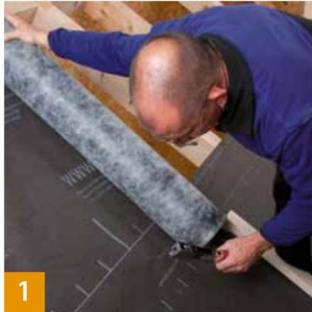
Bahn parallel zur Traufe mit der blauen bzw. dunkelgrauen Seite nach oben einbauen. Befestigung der Bahnen erfolgt feuchteschutz im oberen Drittel des Überlappungsbereichs der später überdeckenden Bahn und unterhalb der Konterlattung. Verzinkte Klammern (mind. 10 mm breit – 8 mm lang) verwenden. Befestigungen dürfen nicht in Bereichen erfolgen, in denen Wasser gesammelt abfließt (z. B. in Kehlen).
