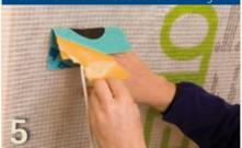
Runde Durchdringungen mit EPDM-Manschetten abdichten. Kabel-Manschetten sind selbstklebend. Rohr-Manschetten mit TESCON VANA luftdicht an Untergrund verkleben. Klebebänder fest anreiben.
