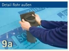
pro clima EPDM-Manschette über das Rohr ziehen und wasserführend mit TESCON VANA auf dem Unterdach verkleben. Oberhalb der Durchdringung Folien-Rinne ausbilden (s. 9b).
