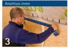
Für luftdichte Anschlüsse von Dampfbremsen an glatte, nicht mineralische Untergründe wie z.B. Holzwerkstoffplatten oder gehobeltes Holz TESCON VANA mittig ansetzen und Zug um Zug verkleben.
