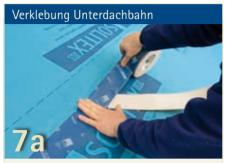
TESCON VANA ist für die Verklebung von Unterdächern geeignet. Band mittig auf der Bahnenüberlappung ansetzen, abwickeln und Zug um Zug verkleben. Band fest anreiben! Auf ausreichenden Gegendruck achten.
