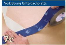
Unterdächer aus Holzwerkstoffplatten (MDF) mit TESCON VANA verkleben. Band mittig auf dem Plattenstoß ansetzen, abwickeln und Zug um Zug verkleben. Band fest anreiben! Holzweichfaserplatten mit dem TESCON PRIMER AC grundieren.
