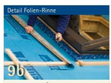
Folienstreifen in die Überlappung der nächsten durchlaufenden Dachbahn führen und verkleben. Freies Ende des Streifens umschlagen und an Traglattung fixieren. Feuchtigkeit durch unterbrochene Konterlatte ins Nachbarfeld ableiten.
