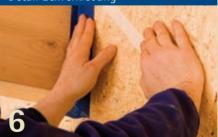
Eckanschlüsse mit dem Eckklebeband pro clima TESCON PROFIL herstellen. Einen Streifen der doppelt geteilten Trennfolie abziehen und ersten Schenkel verkleben. Anschließend verbliebene Trennstreifen abziehen und zweiten Schenkel verkleben.
