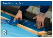
Unterdachbahnen (z.B. pro clima SOLITEX) an nichtmineralischen glatten Oberflächen wie z.B. Dachflächenfenster mit TESCON VANA anschließen. Oberhalb der Durchdringung Folien-Rinne ausbilden (s. 9h)
