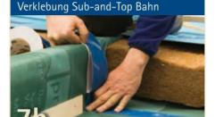
Bei der Verklebung von Sanierungs-Dampfbremsen (z.B. pro clima DASATOP) TESCON VANA mittig auf der Bahnenüberlappung ansetzen, abwickeln, sorgfältig in die Ecken führen und verkleben. Band fest anreiben! Auf ausreichenden Gegendruck achten.
